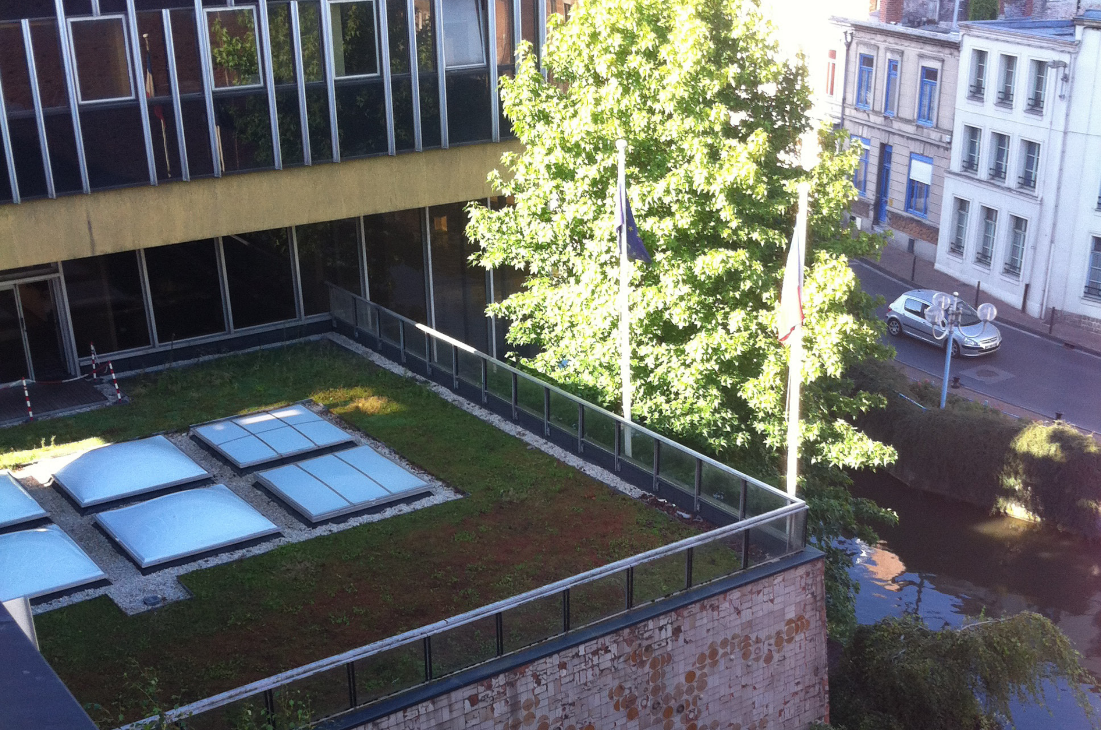
Douai - végétalisation des toitures terrasses du palais de justice - 2012 - 80.000 € H.T.
